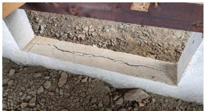
基礎の傷み具合をひとつひとつ丁寧に調査し、すべてのひび割れ等を補修した後に、工期が短く、優れた先端技術を使って耐震補強しています。
