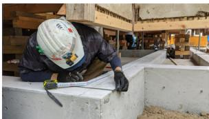
基礎は、昔ながらの石場建てから揚げ前工事で家全体を持ち上げて現代の住宅と同じ、鉄筋コンクリートのべた基礎を造っています。この基礎を利用して、床下の断熱は、基礎断熱を実現しました。
